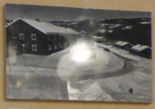
De første rom i skolebibliotek og kurscenter for døve i Trondheim.
